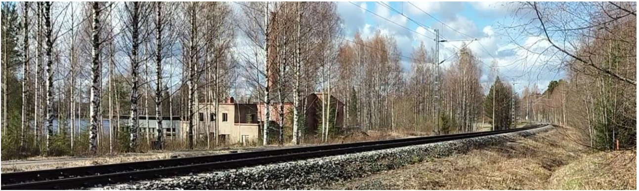
Kuva 24: Entinen saha (nykyinen voimalaitos) 2025
