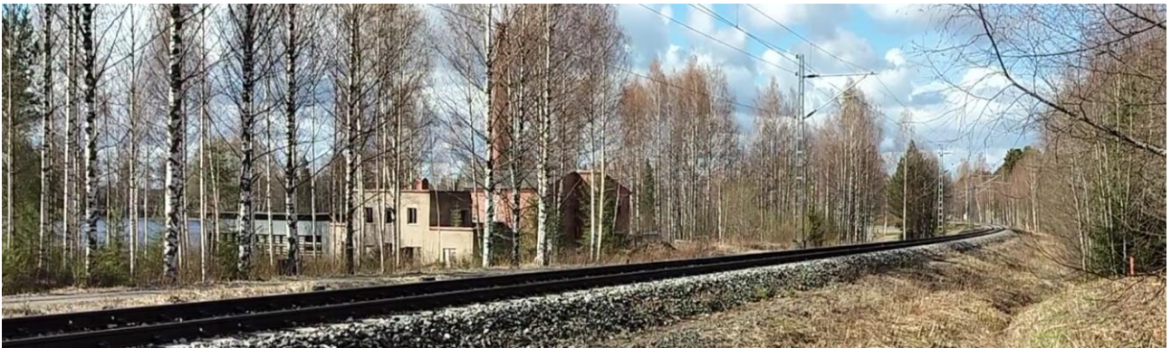
Kuva 22: Entinen saha, nykyinen voimalaitos, 2025
